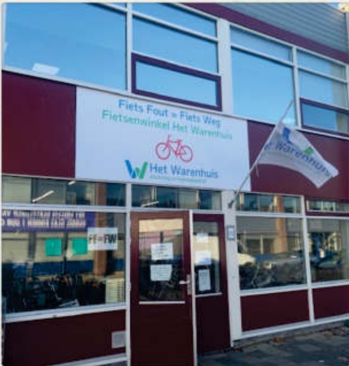
NIEUWE BORDEN OP GEVEL
