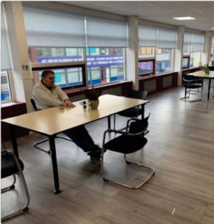
NIEUWE VLOER & RADIATOR ONBOUW KANTINE
